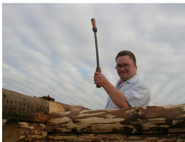
Afbarkning med svensk barkkniv fra Gränsfors.
