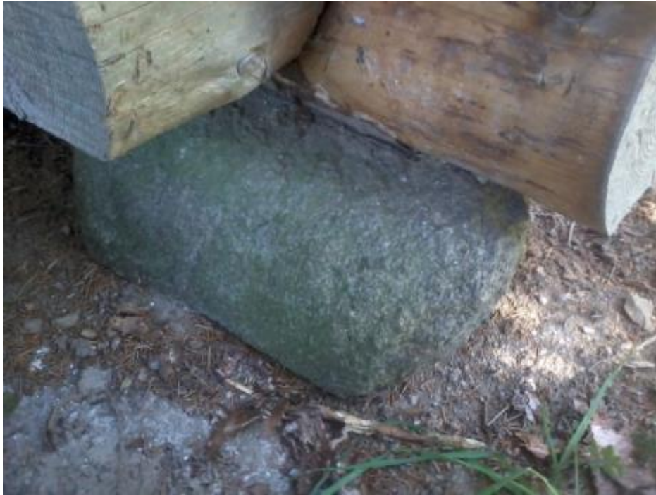
Marksten på støbt underlag, Godthåb Mølle, sat i 1998.
