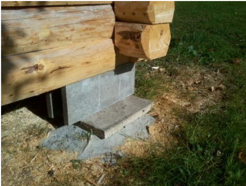
Midlertidig opstilling med sand, flise og fundablok, Jyderup.
