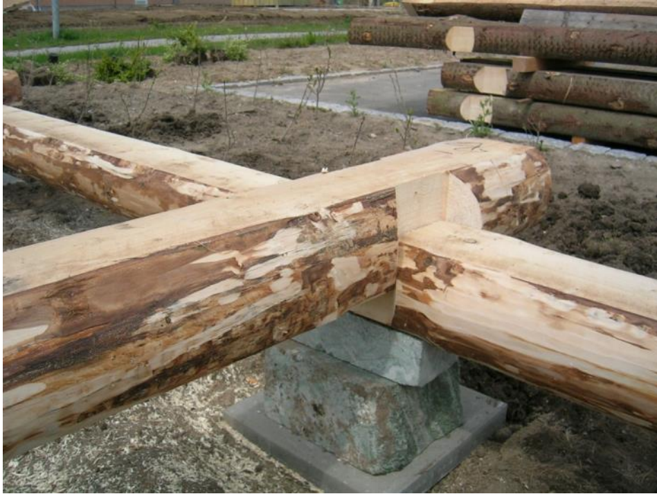
Granit fra stenhuggeriet med flise som underlag, Svinninge.
