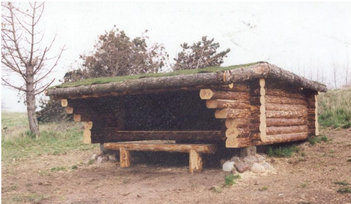
Støbt fundament med indsatte sten, Røsnæs
