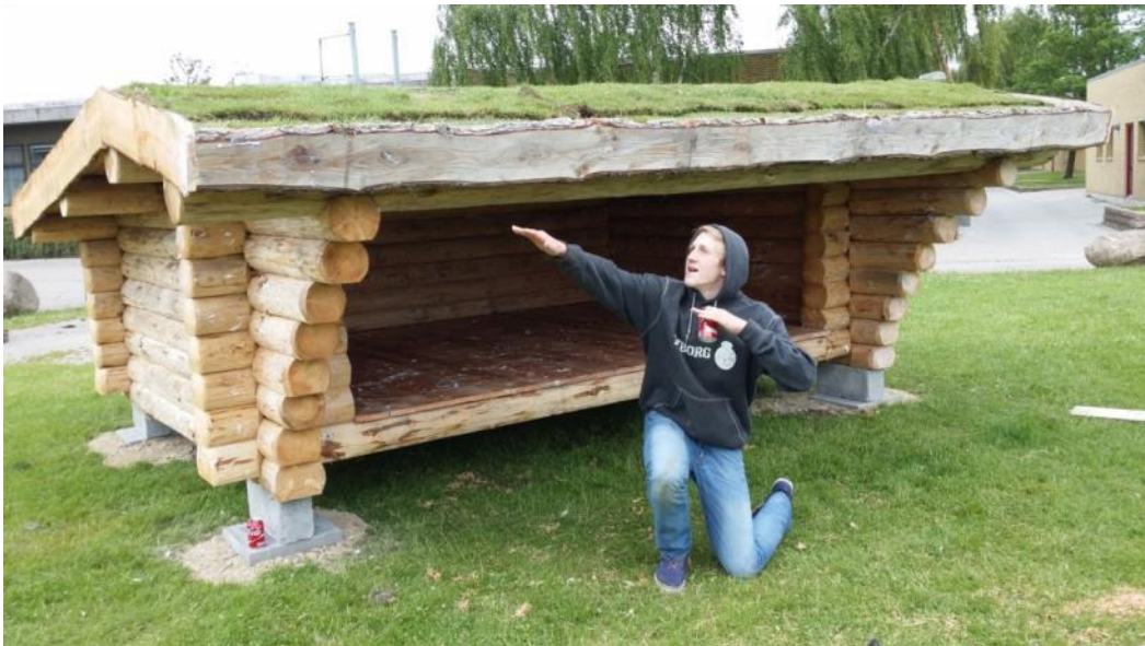
Store kantblokke på fliser, Skævinge
