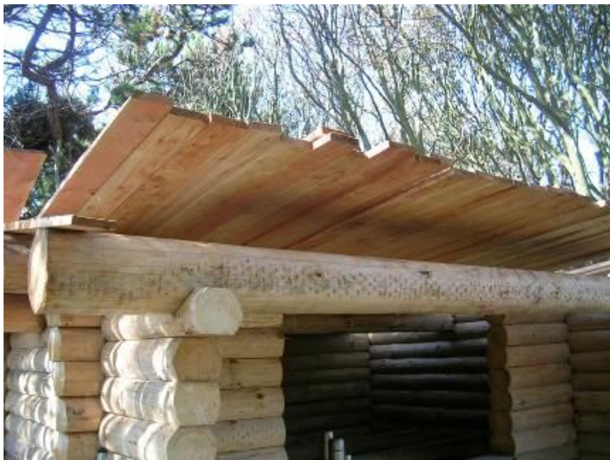
Alle tagbrædder er nu lagt op i fuld længde.
