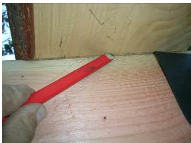
Der streges på undersiden af sternbrættet.
