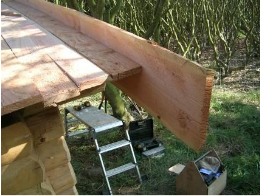
Her er den ene vindskede sat op og skruet fast i bag- og mellemåsen. Den stikker et stykke bagud.
