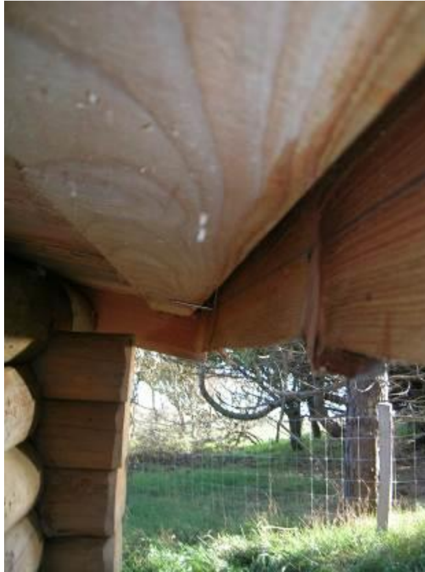
Sternen bagtil er sat op med vinkelbeslag og afstand til tagdryppet.
